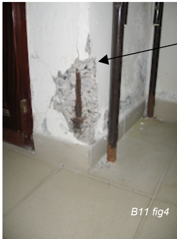
Eclatement d'un pied de poteau
